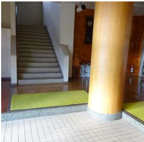
体育館階段の昇降機設置
