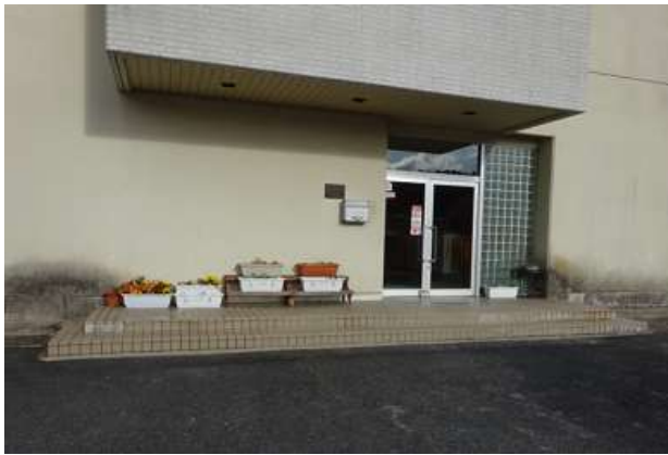
小学校玄関のスロープ設置
