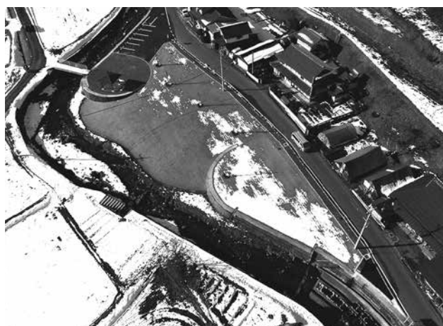
ポケットパーク整備工事 第1・2工区(戸島地内) 事業量 A=1,901\text{m}^2 事業費 13,953千円
