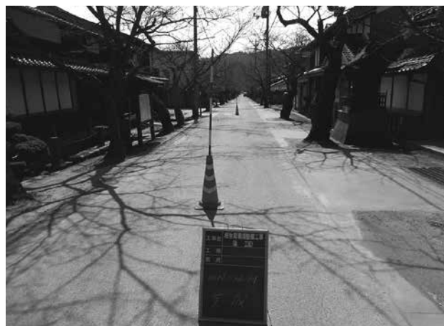
桜生育環境整備工事 第1～6工区(町地内) 事業量 L=426.4\text{m} A=556\text{m}^2 事業費 32,475千円
