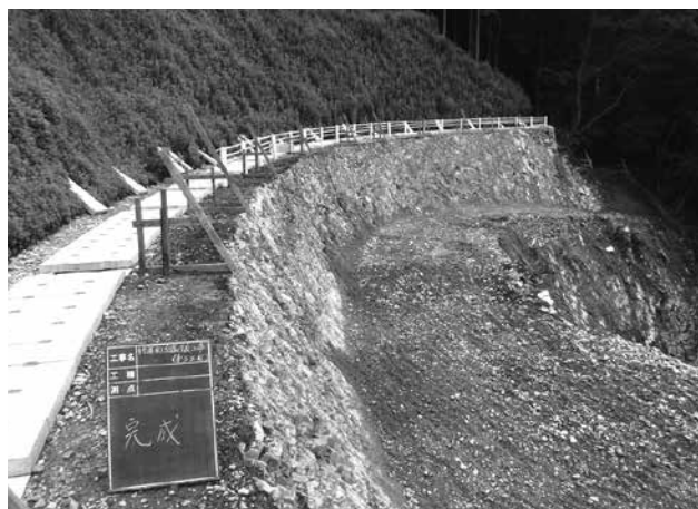
村道田浪線改良工事 第3工区(堂ヶ原地内)繰越含む 事業量 L=90.0\text{m} W=5.5(7.0)\text{m} 事業費 26,665千円
