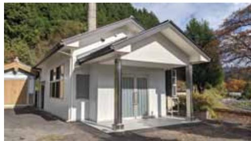
今回の改修では、火葬場棟の外観、ホール、ポーチ、休憩室棟の外壁一部を新しいものに交換し、煙突の補強を行いました。これにより火葬場を長く、快適に使用して頂けるようになりました。
