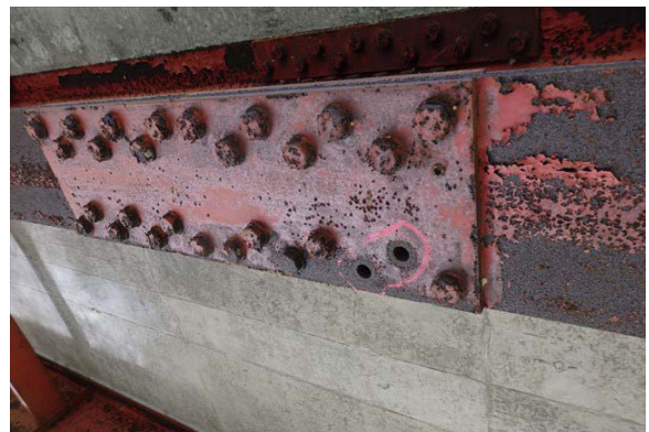
主桁 ボルト欠落
