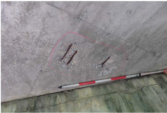
床版 鉄筋露出
