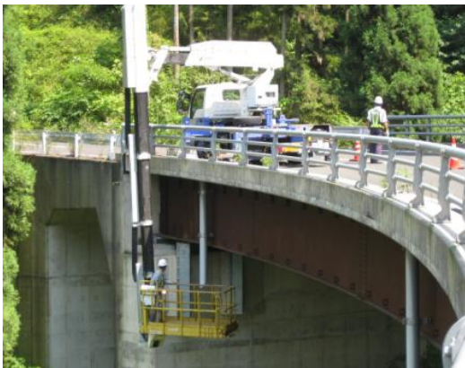
橋梁点検車による点検状況
