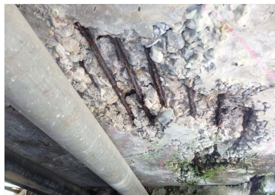
町尻橋（床版 鉄筋露出）
