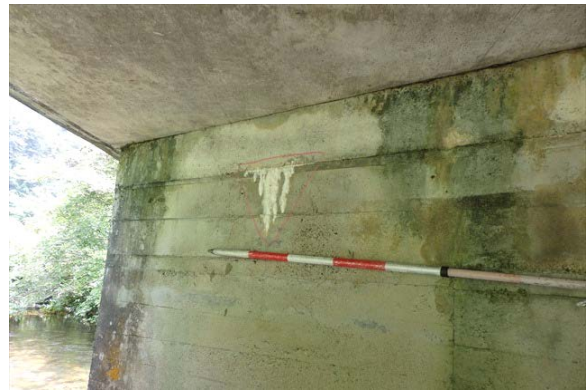
下部工 遊離石灰
