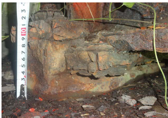
大所橋（支承損傷）
