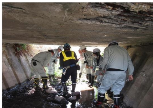
橋梁点検実習状況
