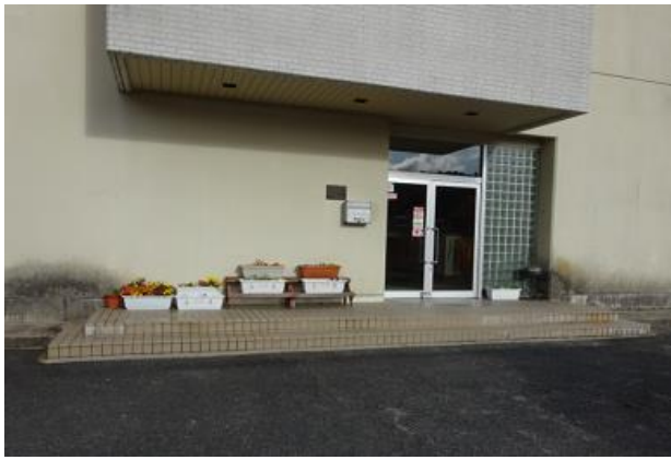
小学校玄関のスロープ設置
