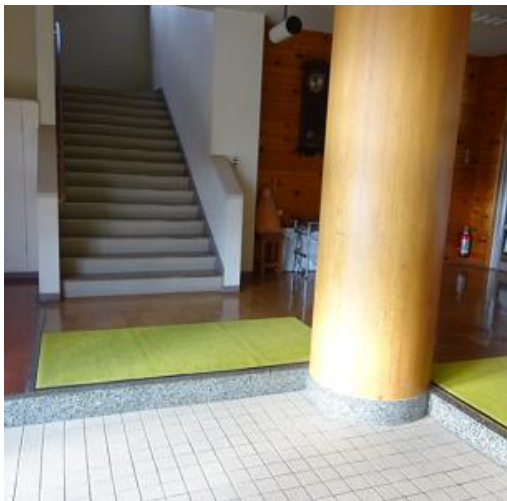
体育館階段の昇降機設置
